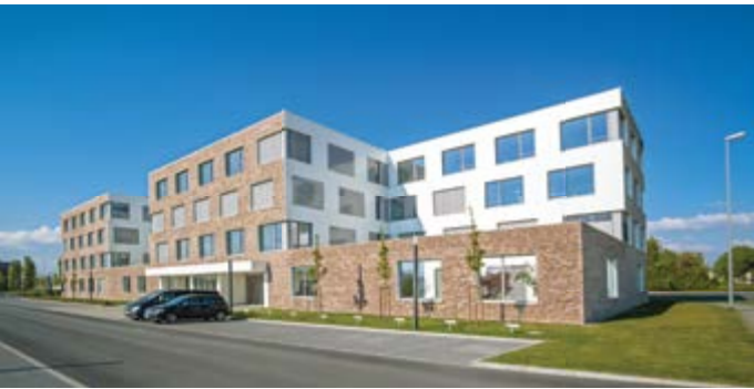
Verborgene Tiefe - Verwaltungsgebäude in Münster, Seite 6
