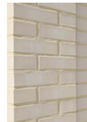
Wohnhochhaus in Antwerpen (B)
