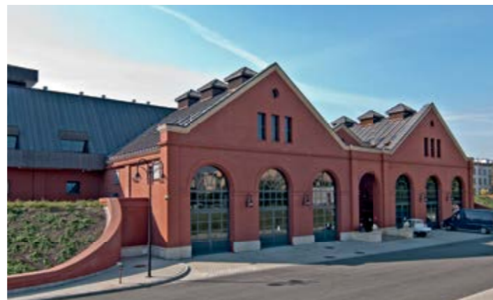
Objekt Neues Wasserwerk in Warschau (PL) Architekten Ryszard Sobolewski, Warschau (PL) Fassade Röben Klinker MELBOURNE, ziegelrot
