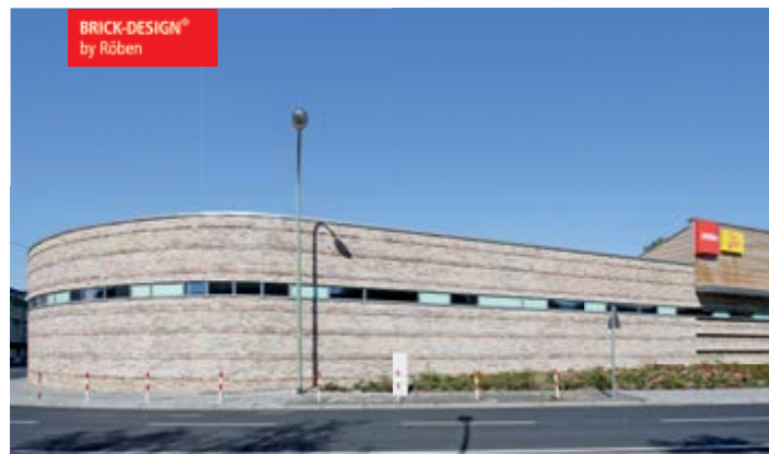
Objekt Supermarkt in Offenbach Architekten Architekturkontor Faller & Krück, Frankfurt/Main Fassade Röben Handform-Riemchen MOORBRAND torfbunt, 14 mm; DYKBRAND flämisch-bunt, 35 mm, BRICK-DESIGN® Sondersortierung
